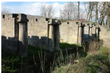
Ryc. 67. Pozostałości XIX-wiecznej śluzi zwanej „jazem ulgi”, odprowadzającej nadmiar wody ze Świśliny, w ramach wybudowanej z piaskowców dolskich inwestycji S. Staszica (fot. P. Gawron)
