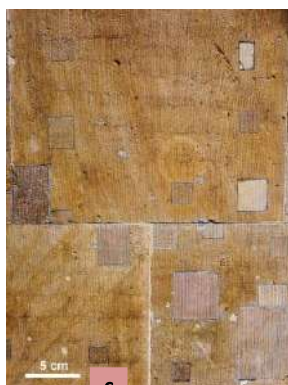
Ryc. 79. Dom „Pod Orłami” przy ul. Jasnej w Warszawie (a), wraz z tablicą na budynku informującą o jego powstaniu oraz fragmentem pierwotnej okładziny ściany, wykonanej z piaskowca dolskiego i późniejsze uzupełnienia z innych rodzajów piaskowca (c) (fot. P. Derkowski)
