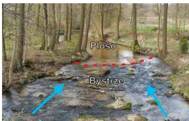
RYC. 58. Odcinek rzeki w Jędrowie, na którym zdeponowane zostały pozostałości po betonowej zaporze. Powstały w tym miejscu bystrze i znajdujące się kilkanaście metrów niżej plosy. Strzałki wskazują kierunek biegu rzeki. Fotografia została wykonana z mostu na nowej zaporze. Fot. P. Przepióra 2016
