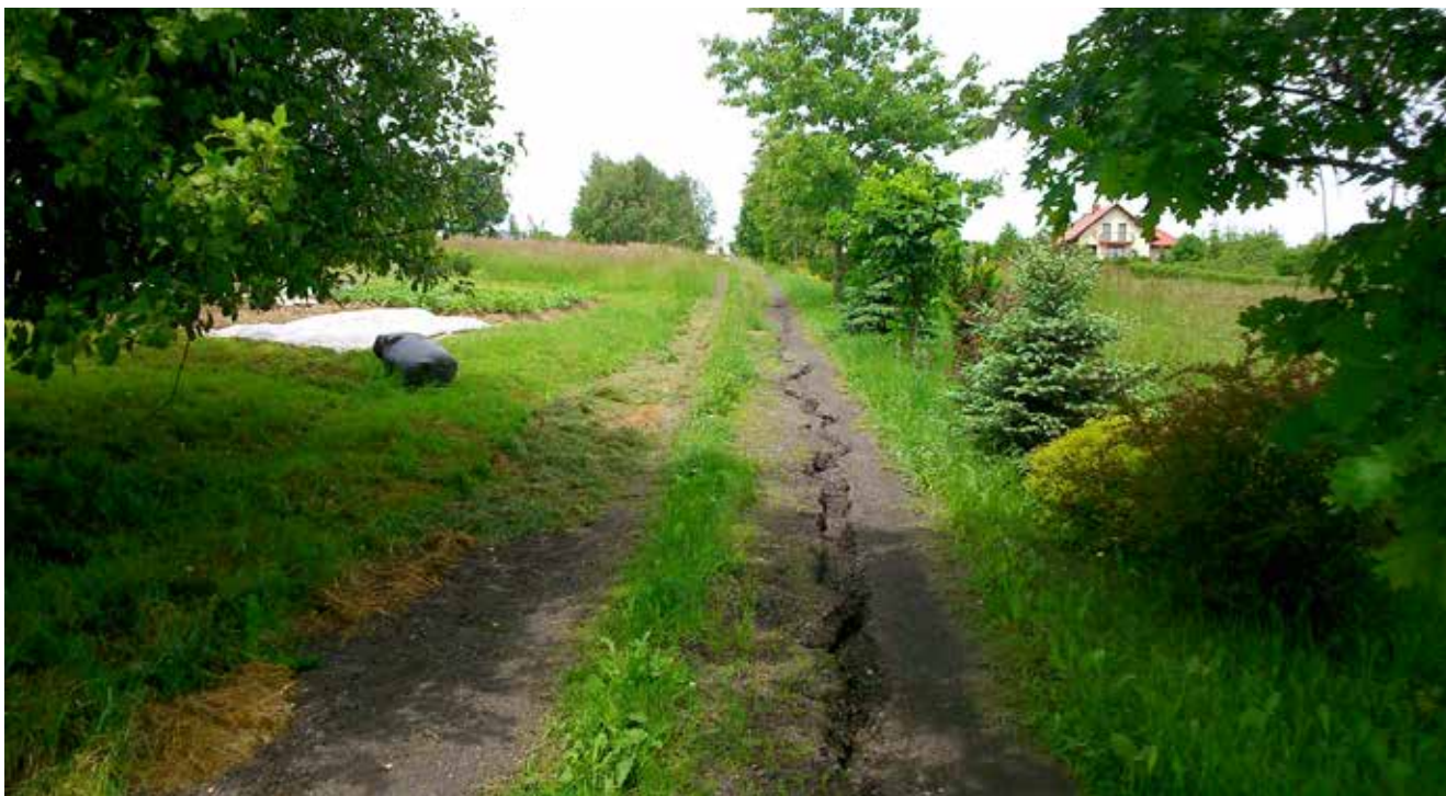
RYC. 63. Bruzdy erozyjne powstałe na wskutek erozji liniowej na drogach polnych na stromych stokach – początkowe stadium rozwoju holwegów. Fot. P. Przepióra 2014
