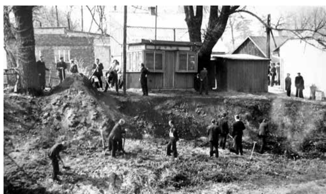
RYC. 56. Budowa nasypów i regulacja koryta rzeki przy dzisiejszej ul. Powstańców w Suchedniowie w 1974 roku w ramach czynu społecznego. Źródło: Piasta 2012
