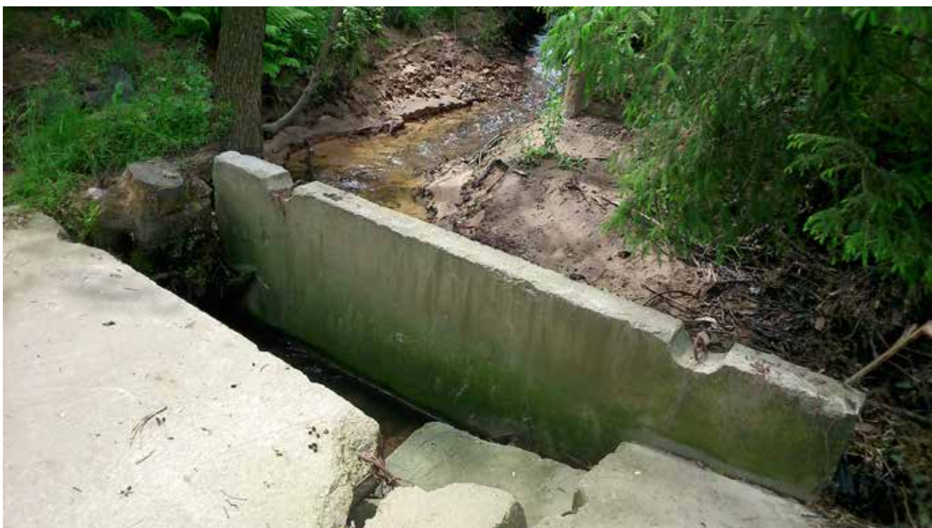
RYC. 23. Prowizoryczna zaporę i przeprawa przez Kamionkę zbudowana z betonowych płyt w górnym odcinku rzeki w Zaciszowicach. Fot. P. Przepióra 2014
