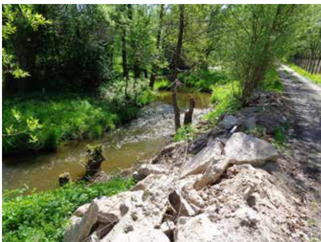
RYC. 81. Zabezpieczenie dojazdu do ogródków działkowych przy użyciu resztek budowlanych na brzegu rzeki. Fot. P. Przepióra 2014
